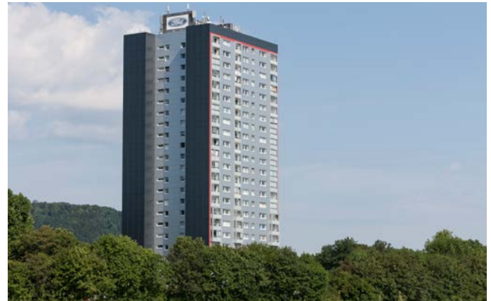
Im 65 Meter hohen Ford-Hochhaus in Saarlouis-Beaumarais regeln nun Honeywell-Produkte die Temperatur der 141 Eigentumswohnungen. Bildquelle: Balco
